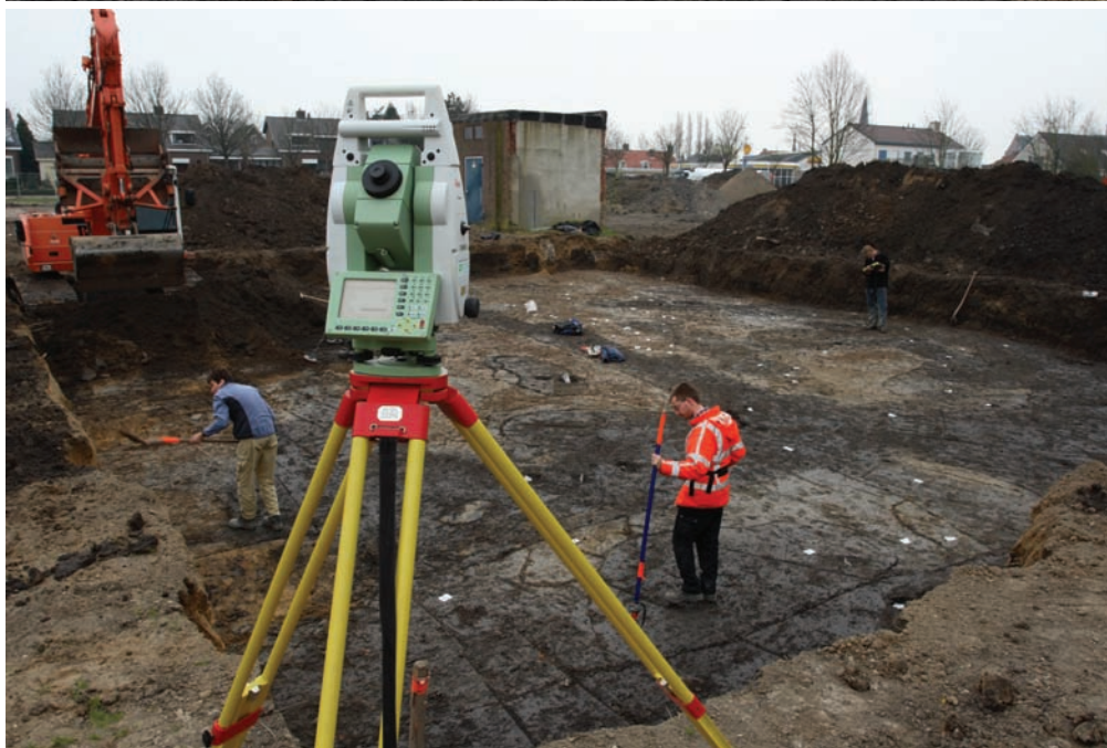
Afb. 1.7 Digitaal inmeten van de grondsporen. Foto's: W. Leeman.
